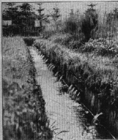
Überall wird der Moorboden mit Kanülen durchzogen, die das durch die Röhren (rechts deutlich sichtbar) abgeleitete Wasser aufnehmen
